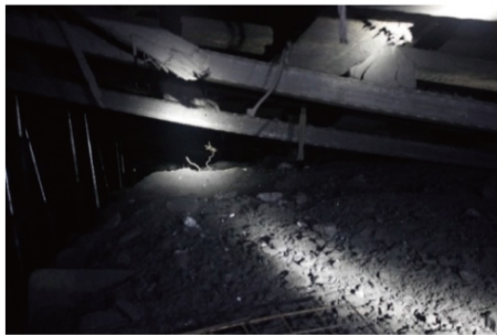
(b) 运输巷现场图片
