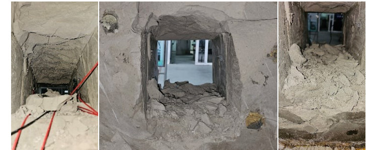
巷道顶板 巷道冲击破坏主视图 巷道底板
